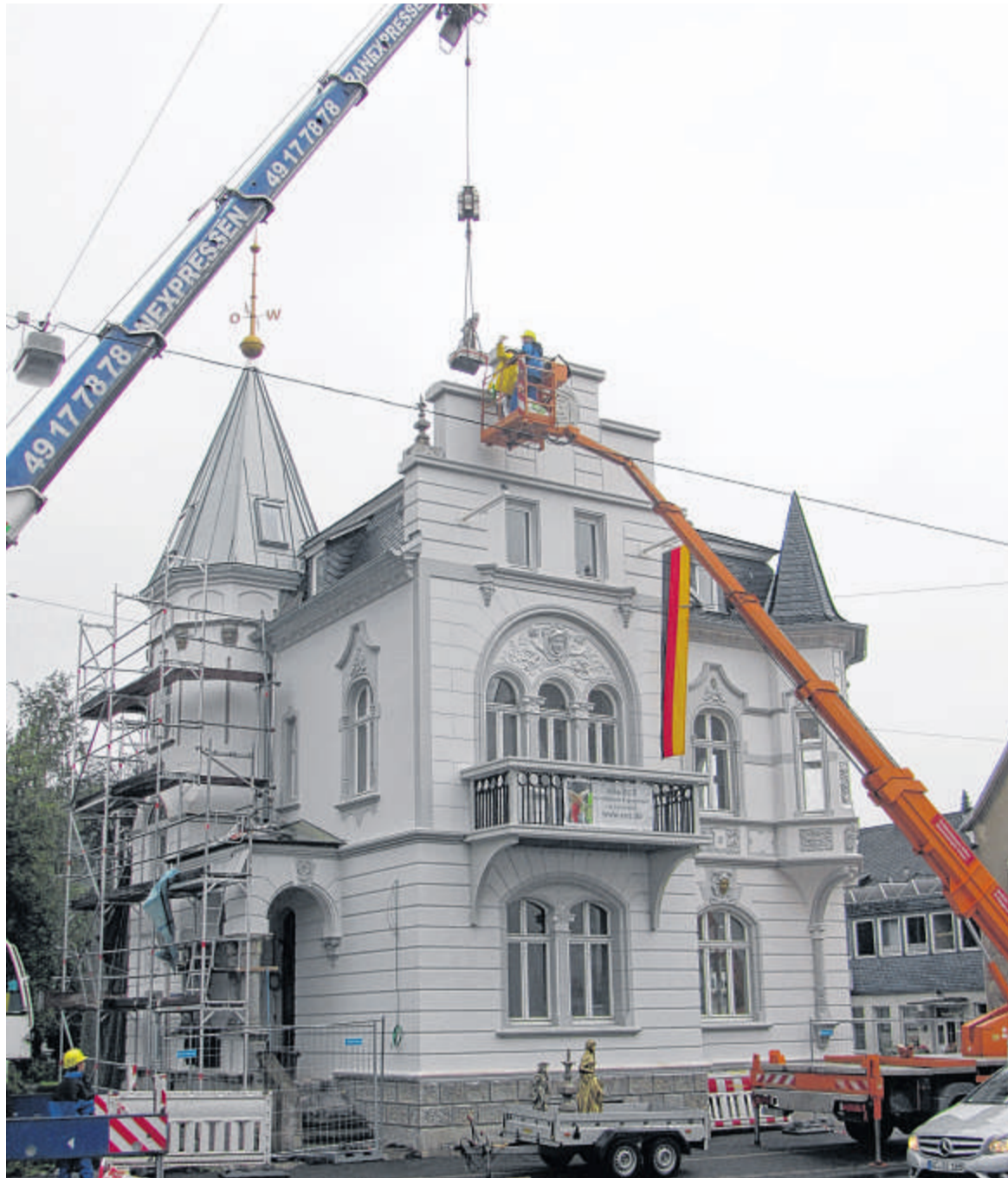
Der Aufwand zur Entfernung der Figuren ist groß. Ein Kran hebt die Skulpturen vom Giebel der Hagelauer-Villa an der Sandstraße herunter und verfrachtet sie auf einen Anhänger.
