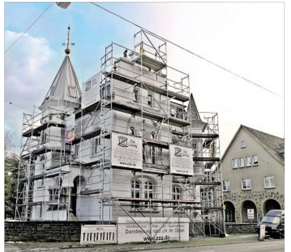
Seit rund fünf Jahren bereits wird das markante Gebäude an der Sandstraße saniert. Bauherr Henning Zoz spricht vom „sportlichen Wettstreit“ mit den Behörden. Foto: ch
